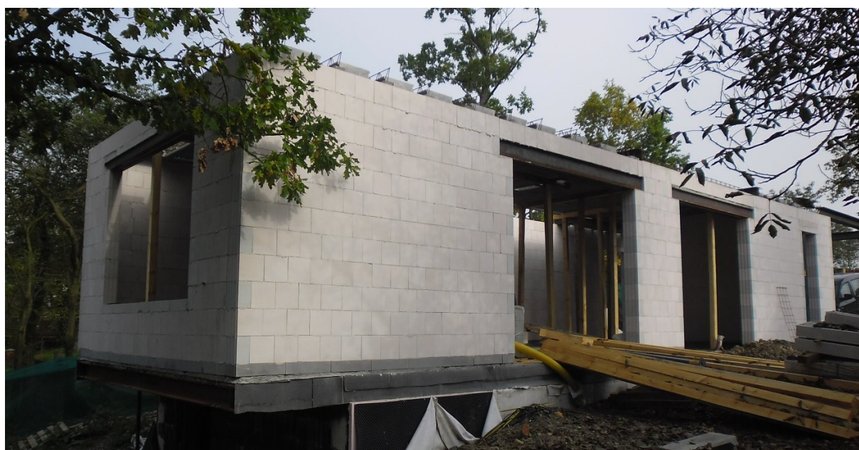
Obr. č. 22: Zděný energeticky pasivní dům v obci Davle [5]
