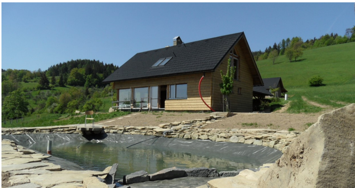
Obr. č. 21: Energeticky pasivní dům na bázi lehkého dřevěného skeletu v Novém Hrozenkově
